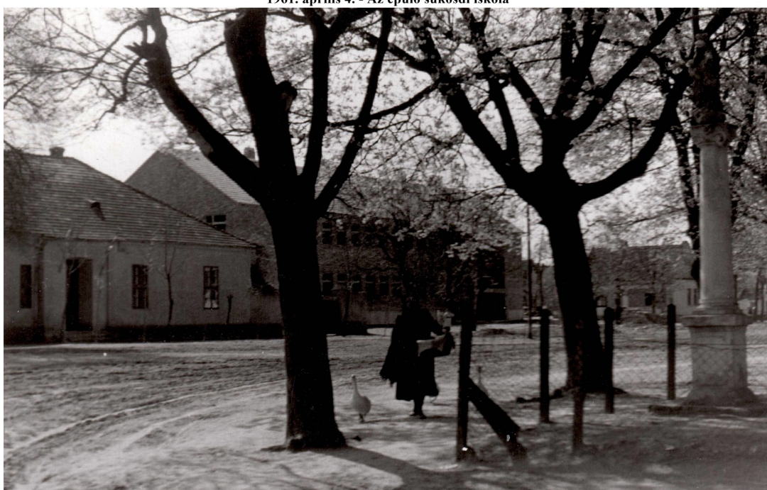
1961. április 4. - Az épülő sükösd iskolája
