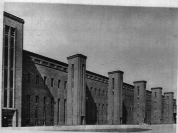
GROSSKRAFTWERK KLINGENBERG. A 30.000 VOLTOS KAPCSOLOHÁZ A CÖPENICKER CHAUSSÉE FELŐL. Tervezték: Klingenberg és Issel építészek
