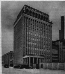
GROSSKRAFTWERK KLINGENBERG. FŐBEJÁRÓ A JÓLÉTI INTÉZMÉNYEK ÉS AZ IRODÁK ÉPÜLETÉVEL Tervezték: Klingenberg és Isenel építészek
