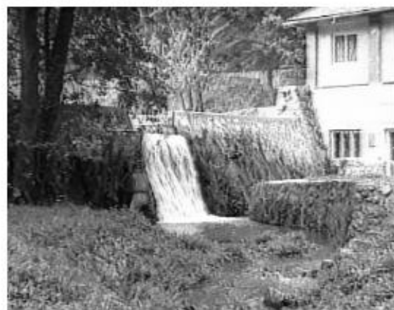
A völgyváró gát. Jobb oldalt a gépház
