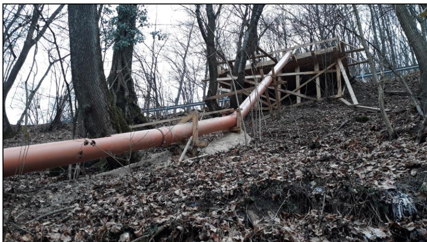
A Kőhorogban kanyargó útról az ömlesztett építési anyag (murva, kavics) helyszínre mozgatásához külön csúszdapályát építettek (Fotó: Szmorad Ferenc)
