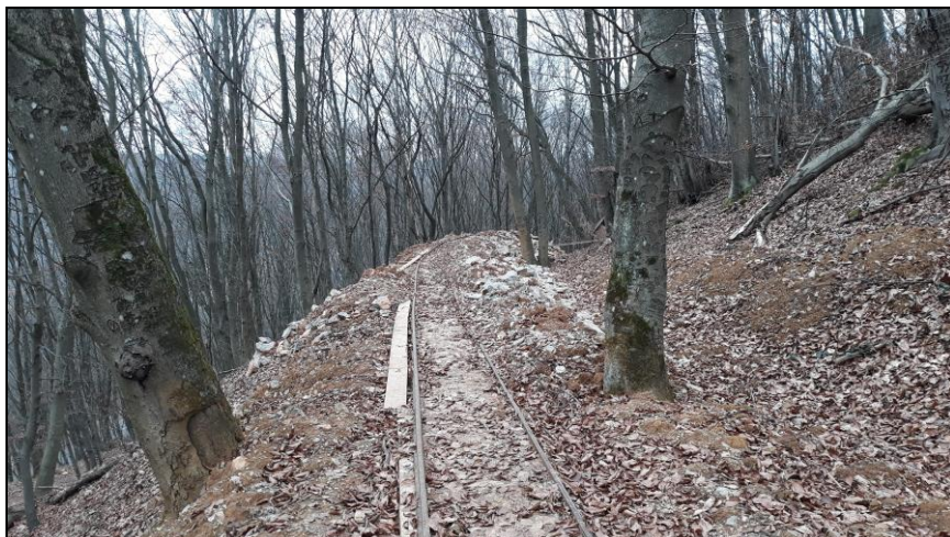
A barlangi munkálatok során kitermelt, jelentős mennyiségű kötörmelékét és agyagot a felszínre csillepályán juttatják ki (Fotó: Szmorad Ferenc)
