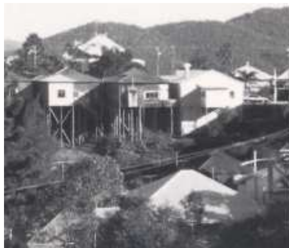
9. ábra – Magas cölöpalapok Brisbane meredek lejtőin
