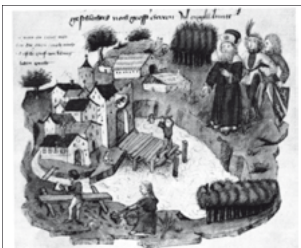
23. ábra Az Alsókapu híd építése Bernben, IV. Hartman felügyeletével (1256) (Forrás: Tschachtlan, 1470)
