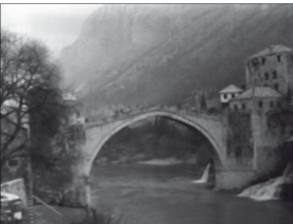
10. ábra A Neretva eredeti hídja Mostarban, ép. 1557 (Fotó: Josephine W. Baker)
