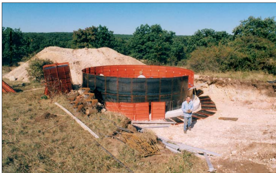
„Műforrás” tárolójának elhelyezése a föld alá
