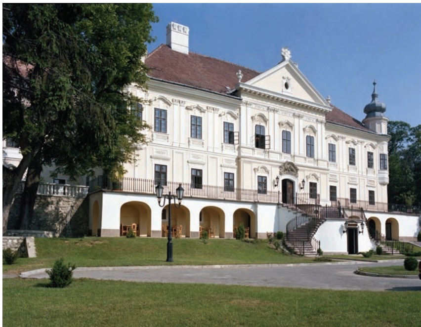
A helyreállított épület az új kétkarú lépcsővel
