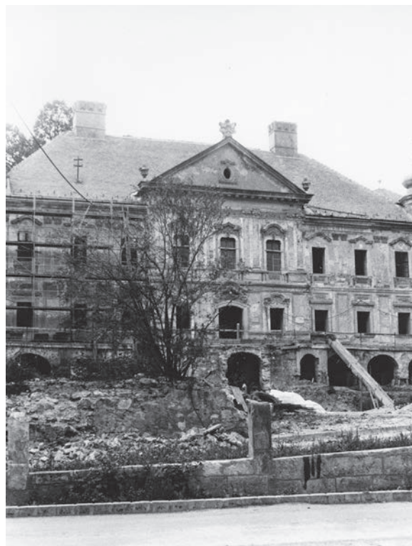
A kastély földszintjének kibontása az 1978–1985 közötti helyreállítás során
