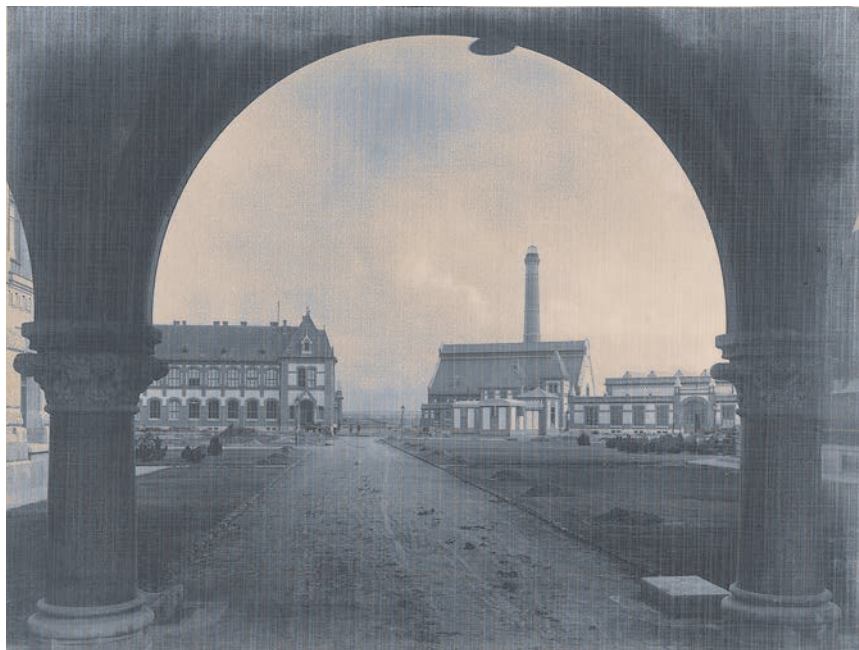
8. kép. Az MT épület, a kazánház és a Géplaboratórium északról, az úgynevezett Sóhajók hídjá alól 1909-ben. (Balogh R. felvétele. Forrás: HAUSZMANN 1909a, 22. o.; BALOGH 1909a, 995. o.; 1909b)
