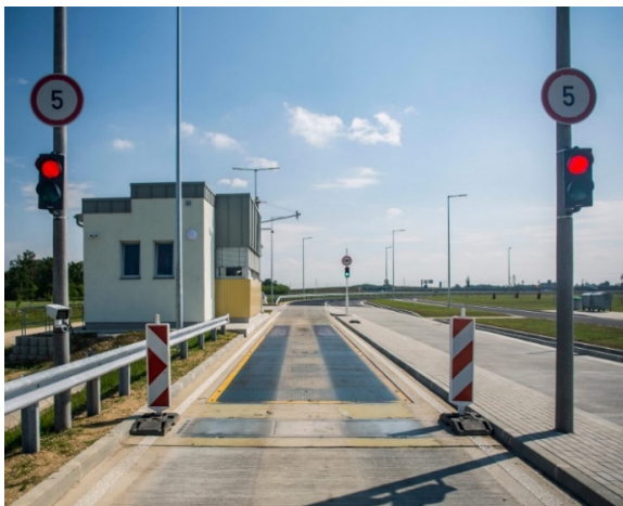
1. ábra (balra): Tengelysúly- és össztömegmérleg (Vámoscsalád pihenő) [1].
