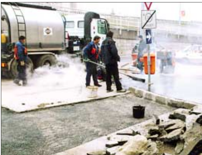
Útburkolati és járdahibákat javítottak ki a szakemberek múlt év decemberének közepén a Tavasz utcánál
