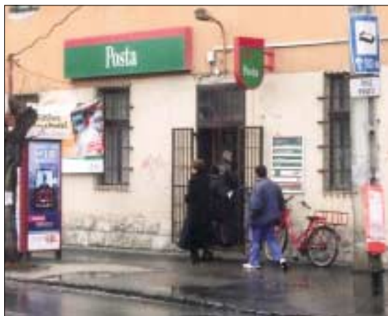
A rossz állapotú bérleményből a tervek szerint új helyre, korszerű épületbe kerülne a csillaghegyi posta
