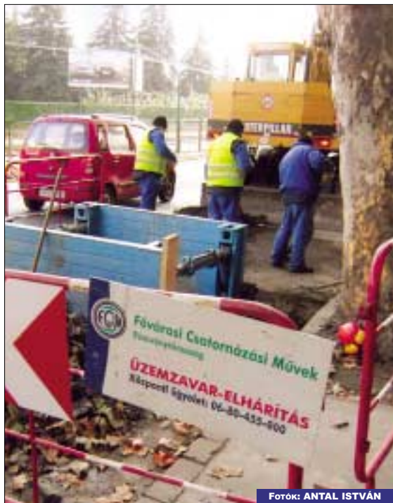
ÚTSZÚKÜLET. Az Árpád fejedelem útján, az Evező utcánál útszűkületre számítsanak a Margit híd felé tartók, mert csatornát javítanak
