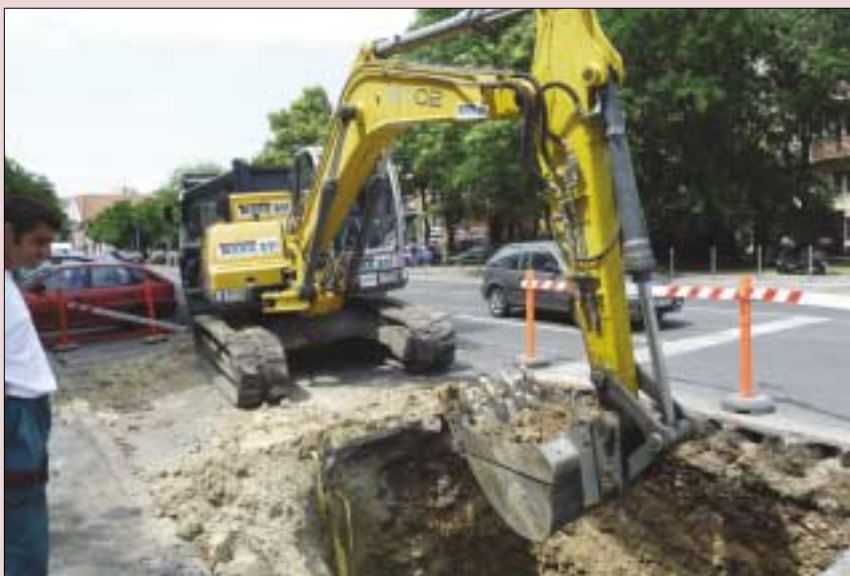
Vízhálózat-felújítás a Szépvölgyi út-Árpád fejedelem útja sarkán
