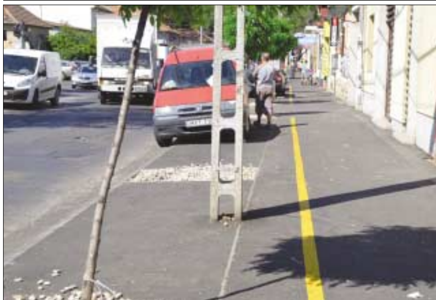
Elkészültek a járda aszfaltozásával a Mátyás király út Batthyány utca-Szentendrei út közötti szakaszán
