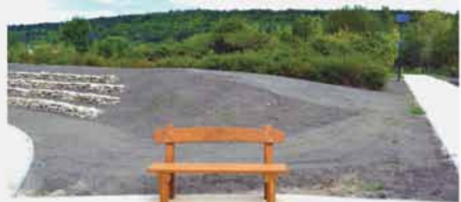
A park közepén, a sétányok találkozásánál amfiteátrum jellegű közösségi tér épül.
