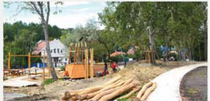
Készül a játszótér a Mészkö parkban, az Ilonamalom Műhely tervezésében és kivitelezésében.
