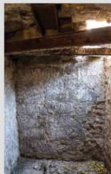
A pince tartószerkezeti megoldásai és a beszakadt födém
