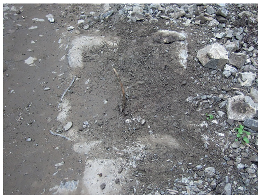
8. ábra: Fedett aknagödör a Kis-Tarac-patak meredek, szűk völgyében vezető úton Forrás: a szerző felvétele
