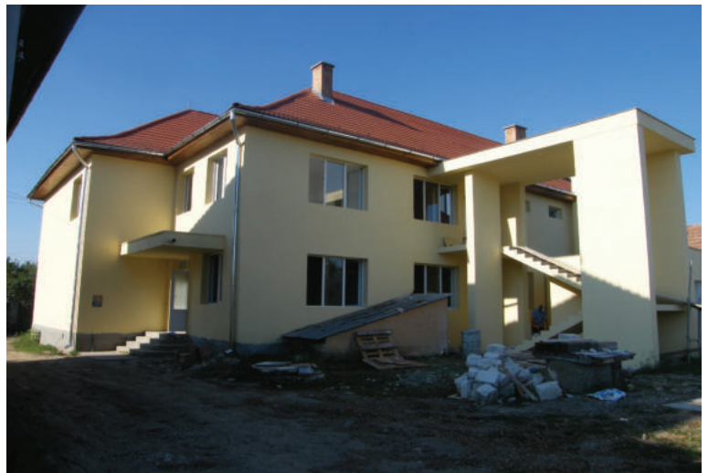
A jenőfalvi óvoda épülete
