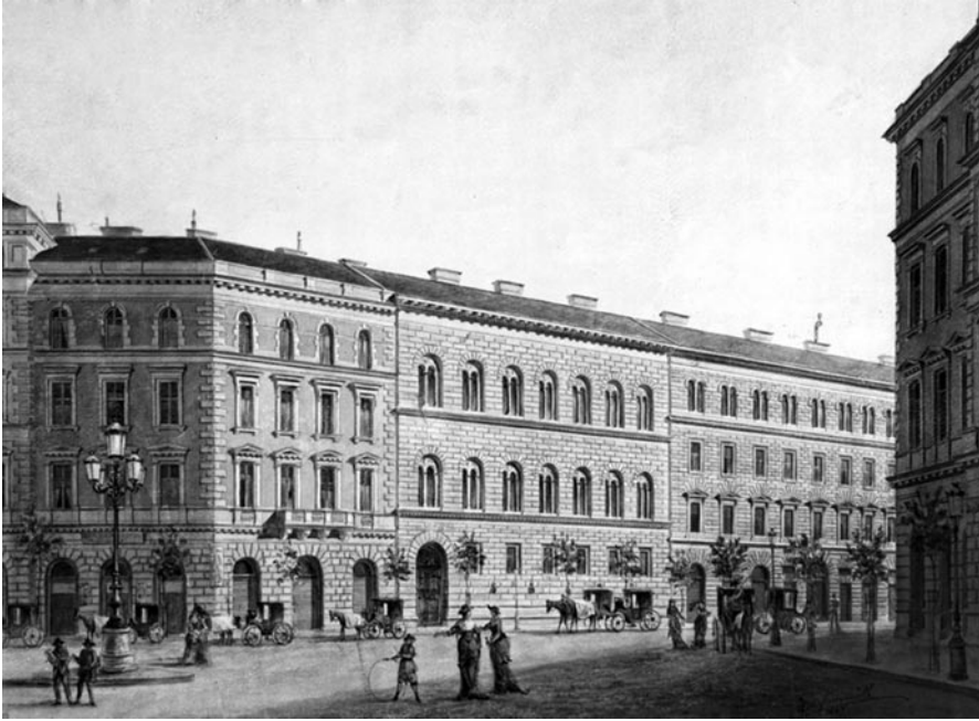
Palazzo Batthyány, 1885, Arch: Alajos Hauszmann
