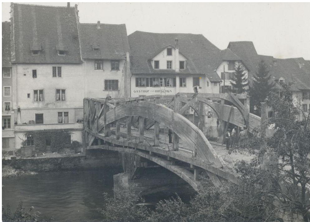
7–8. képek. Mellingen 1794-ben épült ívhídja a Reuss folyón, ugyanaz bontás közben. 14
