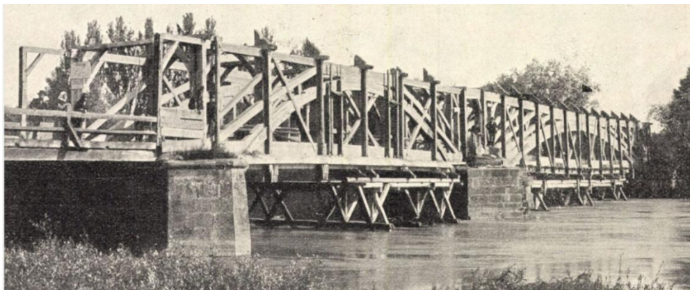
10. kép. A fogarasi híd bontás közben. 26
