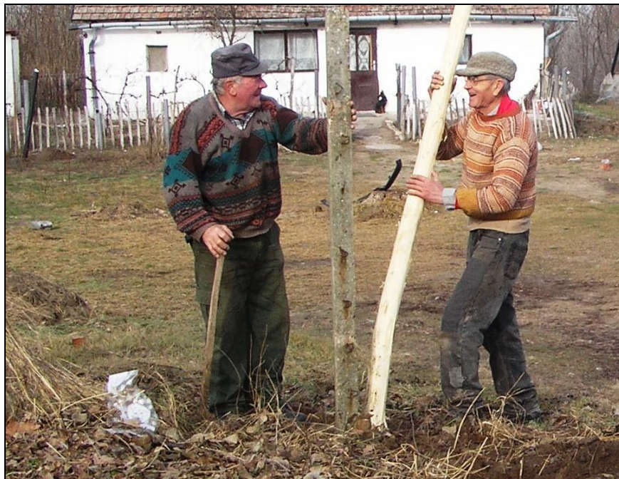
Ábel Vince (balra) a temető kerítés felújításakor (fotó: Molnár Mihály)
