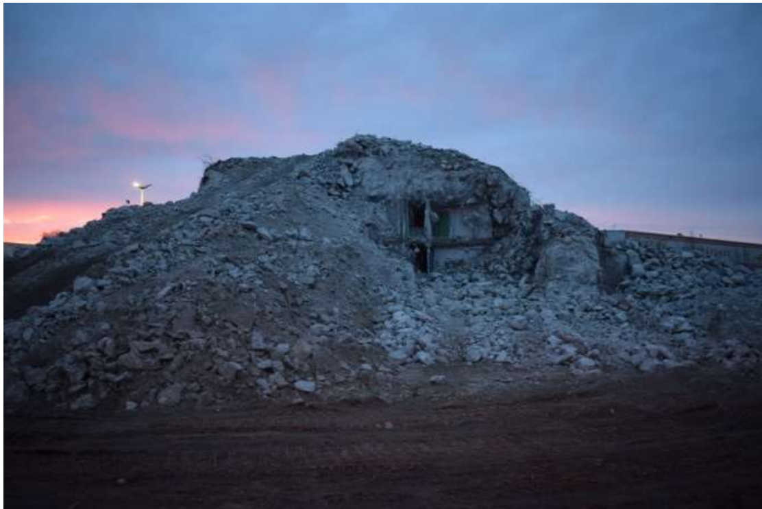
A bunker bontás közben (fotó: Klaniczay, 2024)
