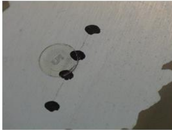
10. ábra repedések a szegecsek között
