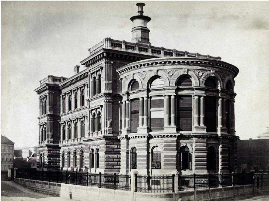
2. kép – A budapesti Mária utcai bőrklinika épülete
