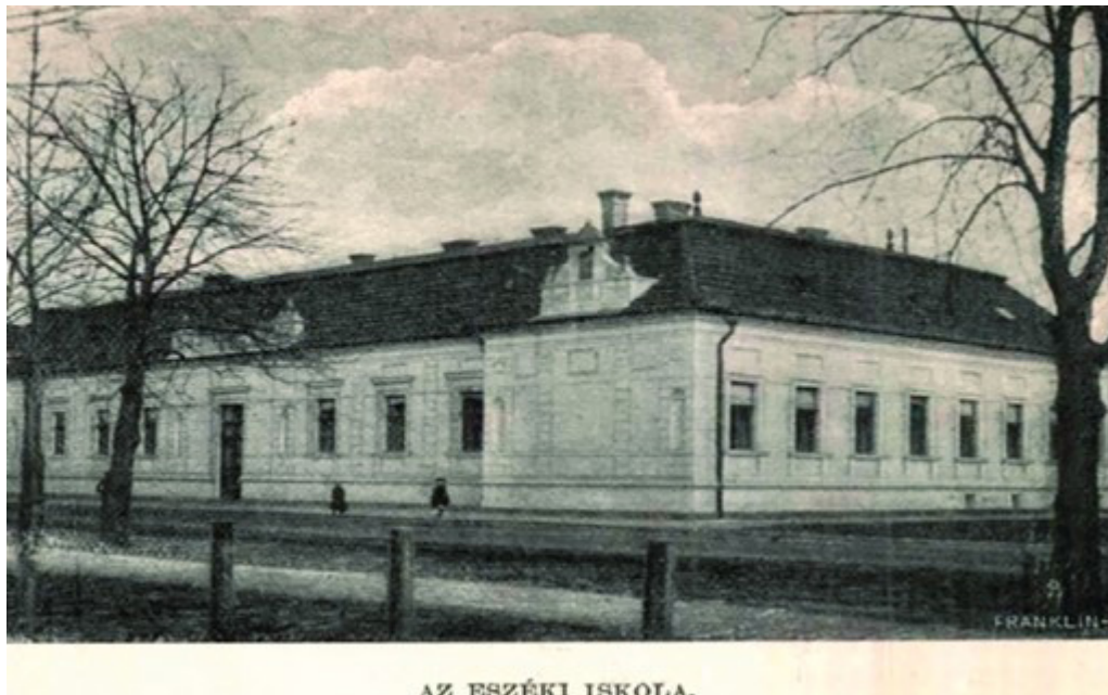
1. kép – Az eszéki magyar tanítási nyelvű elemi népiskola épülete 1897-ben (a mai Radićeva és Gundulićeva sarkán az emeletráépítés és a hozzáépítés előtt)
