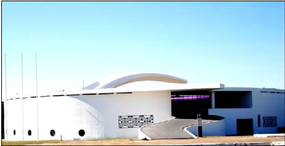
Edifício monumental do Memorial dos Povos Indígenas em 2.984 m 2
