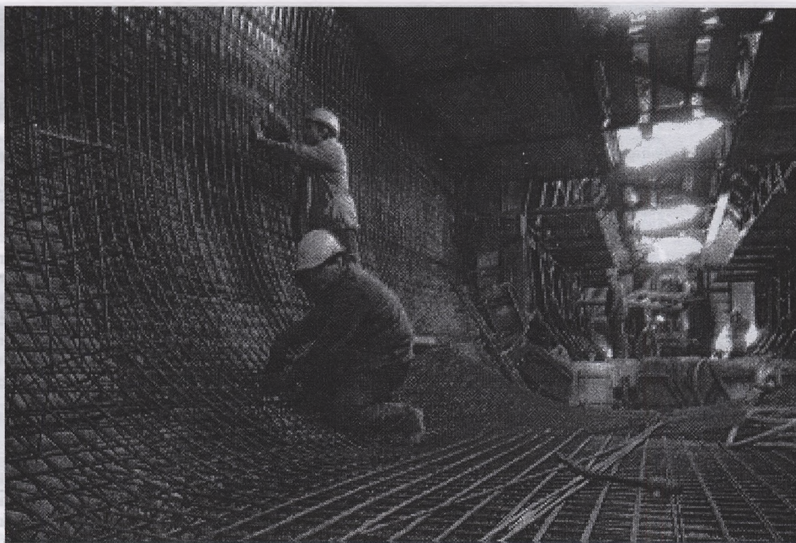
Alagút belsőhöz vasszerelés
