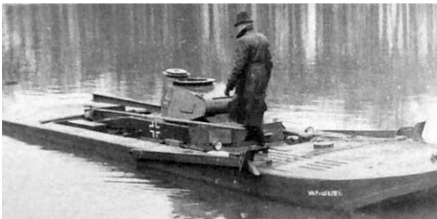
22. ábra. Próbauton a Schwimmpanzer II-es. Láthatóak a jármű oldalára szerelt úszótestek. Az úszóképes páncélos a vízben is harcképes maradt
