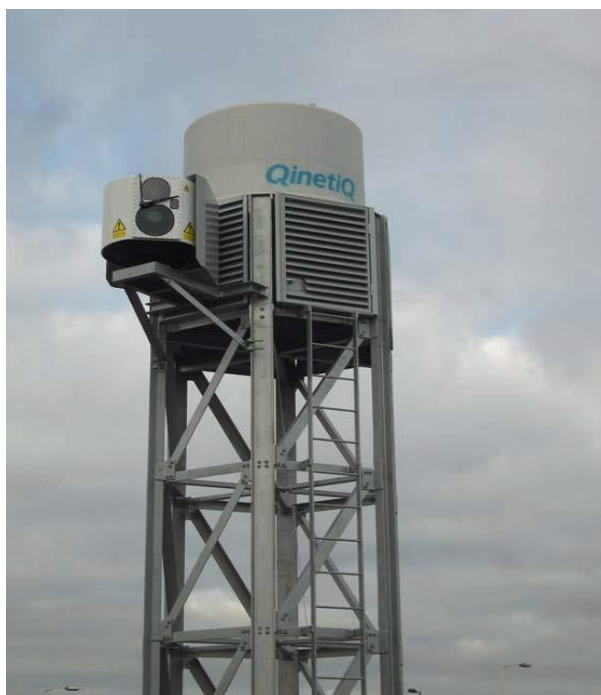
3. számú ábra. London Heathrow repülőtérén található milliméteres rádióhullámokat kibocsájtó berendezés és kamera egy fix toronylábazatra rögzítve. 16
