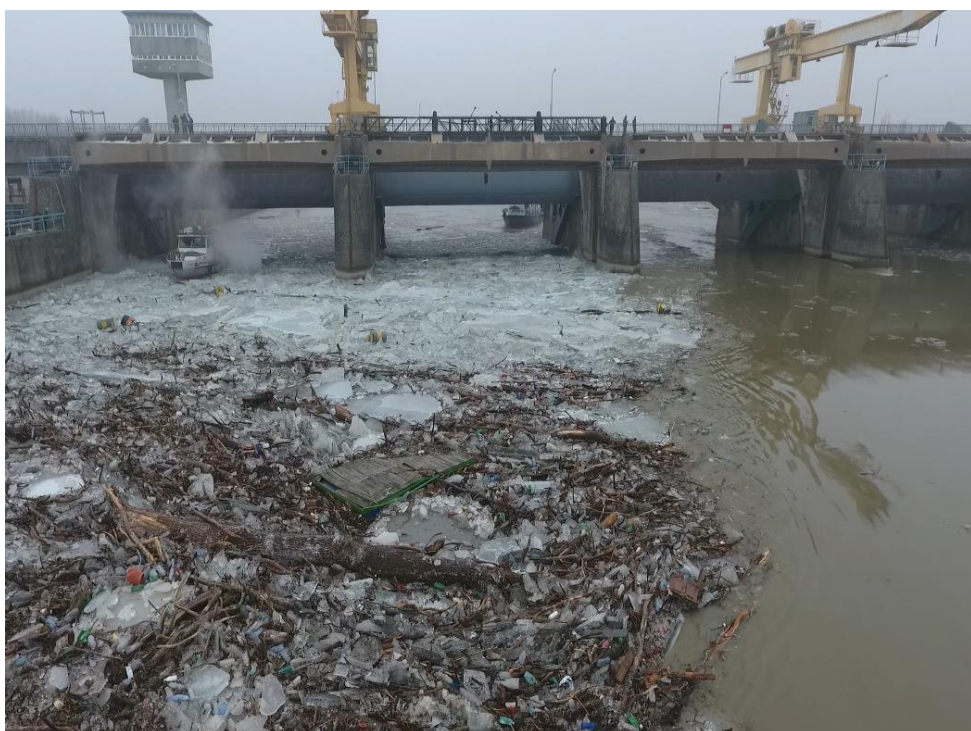
9. számú ábra. Jégtorlasz megszüntetése jégtörő hajókkal a Kiskörei Vízlépcső felvízi oldalán 2017 februárjában (Készítette: FETIVIZIG)
