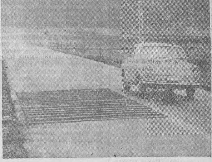
A svájci autóbaleseti statisztika kétes dicsőségű rekordere a Wengli közelében levő útkereszteződés. Minthogy a lassítási felhívások és a stop-táblák nem sok eredményre vezettek, a közlekedési hatóságok hullámos útburkolattal próbálják fekélyesre kényszeríteni a gépkocsivezetőket. Ha csak — mint képünkön is — a vezető ki nem kerül a rázós útszakaszra.
