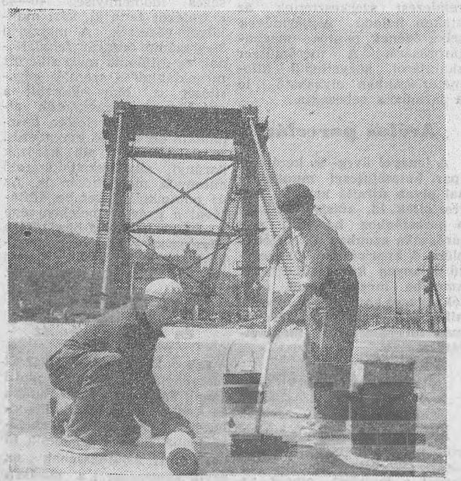
Elkészült az Erzsébet-híd pesti feljárójának betonozása. A hídra felvezető útszakaszt nyugatnemet gyártmányú. Rheparol ragasztott műanyaglapokkal szigetelik.
