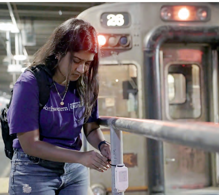
Hőmérséklet-érzékelő felszerelése egy metróállomáson (Forrás: Northwestern University)
