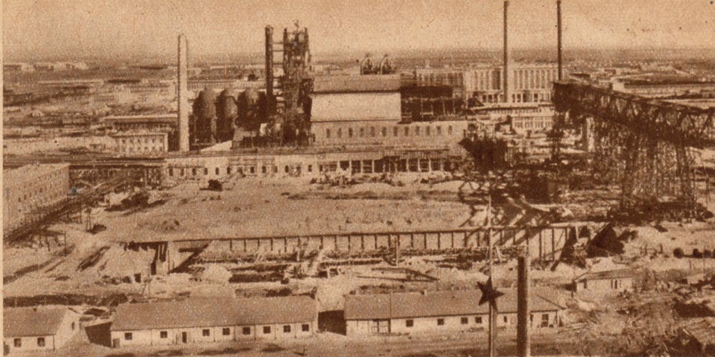
3. kép: Kilátás a koksizólómű felől. Az épülő hatalmas ércraktárok fölött még mozdulatlanul áll az ércrakodó daru, hátrább közepén a kohó emelkedik, balra a léghevítők, jobbra az erőmű épülete látszik
