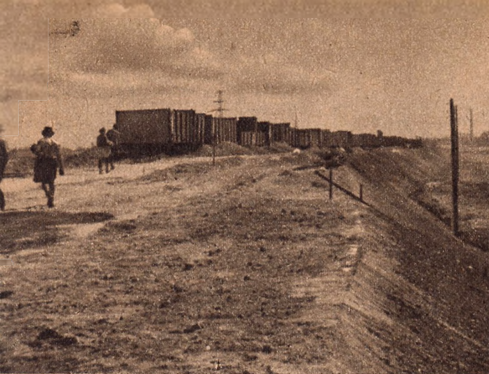
Nyolcméteres töltés vezet fel az új rendezőpályaudvar emeletére.
