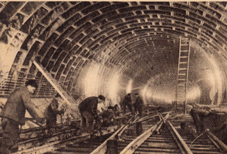
A moszkvai Metro építkezése. Szerelik a síneket az új alagútban
