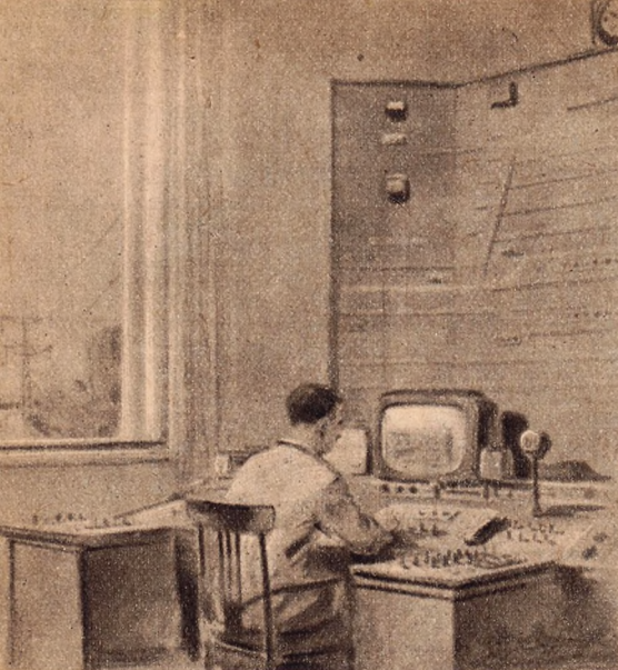
Az állomásokon a forgalom irányítói nemcsak a jelzőberendezéseken, hanem a televíziós készüléken is ellenőrizhetik az automata váltók működését
