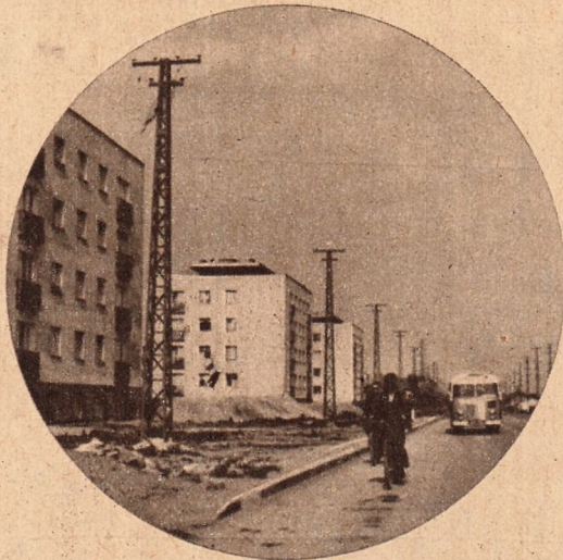
A diósgyőri új munkáslakóházak
