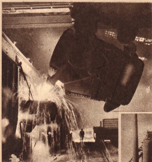
Fent: Vasolvasztás a kombinát Martin-kemencéjében. 1053-ban már 150 fajta kiváló minőségű acélt készítenek. Jobbra: A nyersvasat különleges kocsikkal vasúton szállítják a Martin-kemencékhez.
