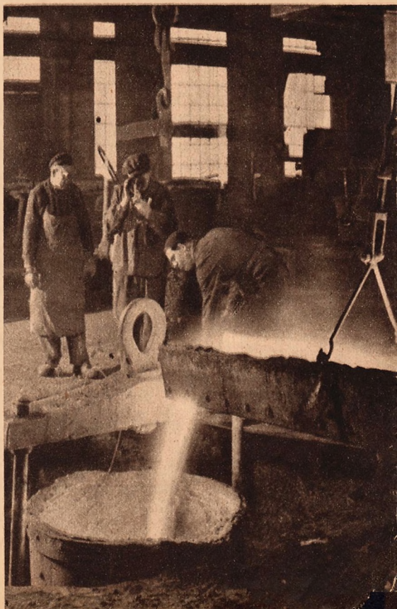
Öntés előtt műszerrel vizsgálják az izzó vasat a diósgyőri kohóban
