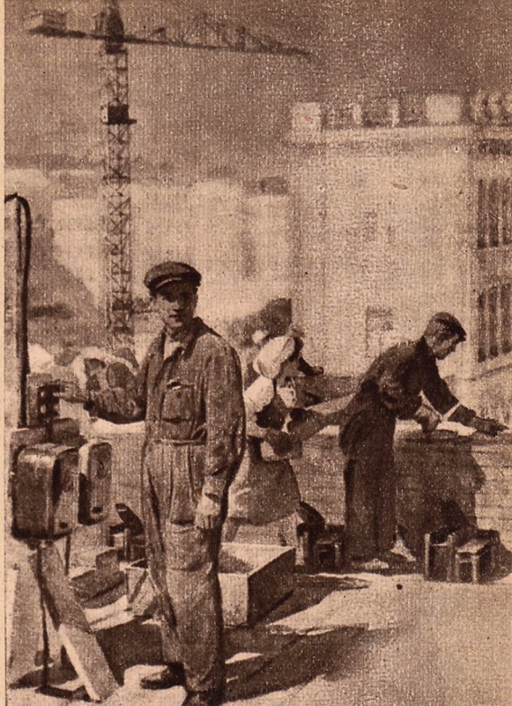
4. Gombnyomásra emelkedik a palló, miközben a kőművesek zavartalanul végzik munkájukat
