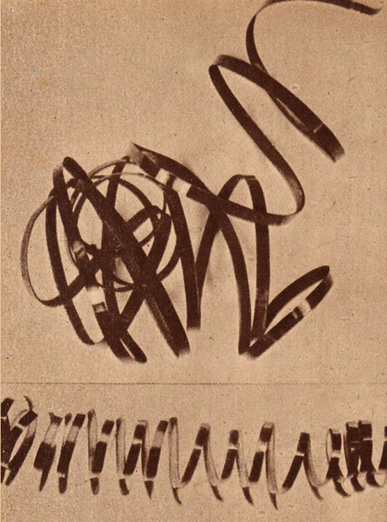
Koleszov-féle késsel vágott forgácsok. Fent 4 mm, lent 2.5 mm széles forgácsok
