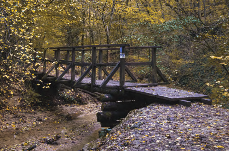
Fahíd a Paprikás-patak felett
