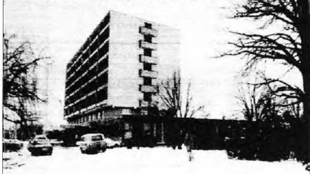
a 60-as években épült épület mai állapota
