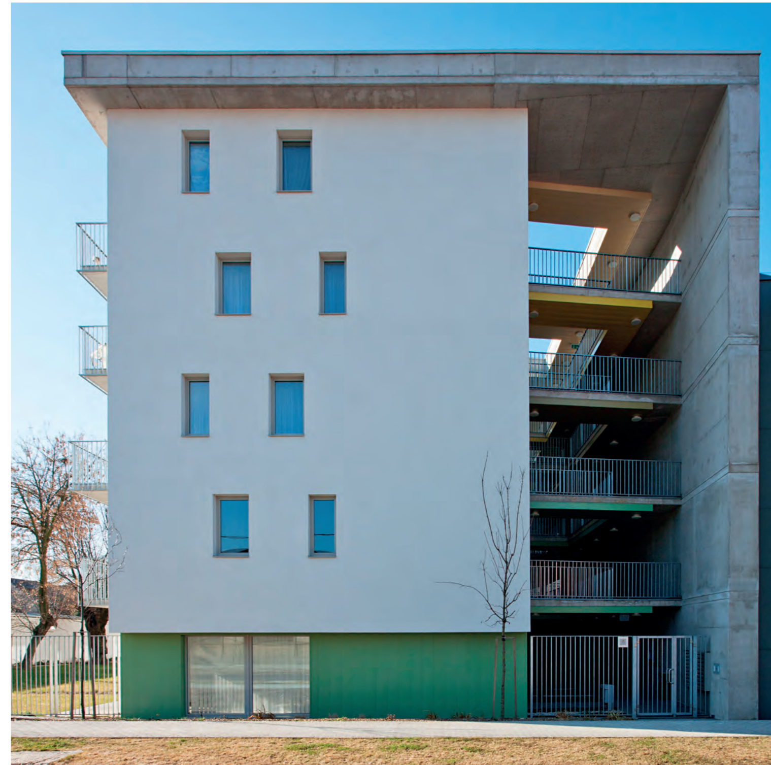
Kompakt tömegformálás, hővesztés-minimalizálás, arányosított üvegfelületek, a tájolás és árnyékolás optimalizálása
