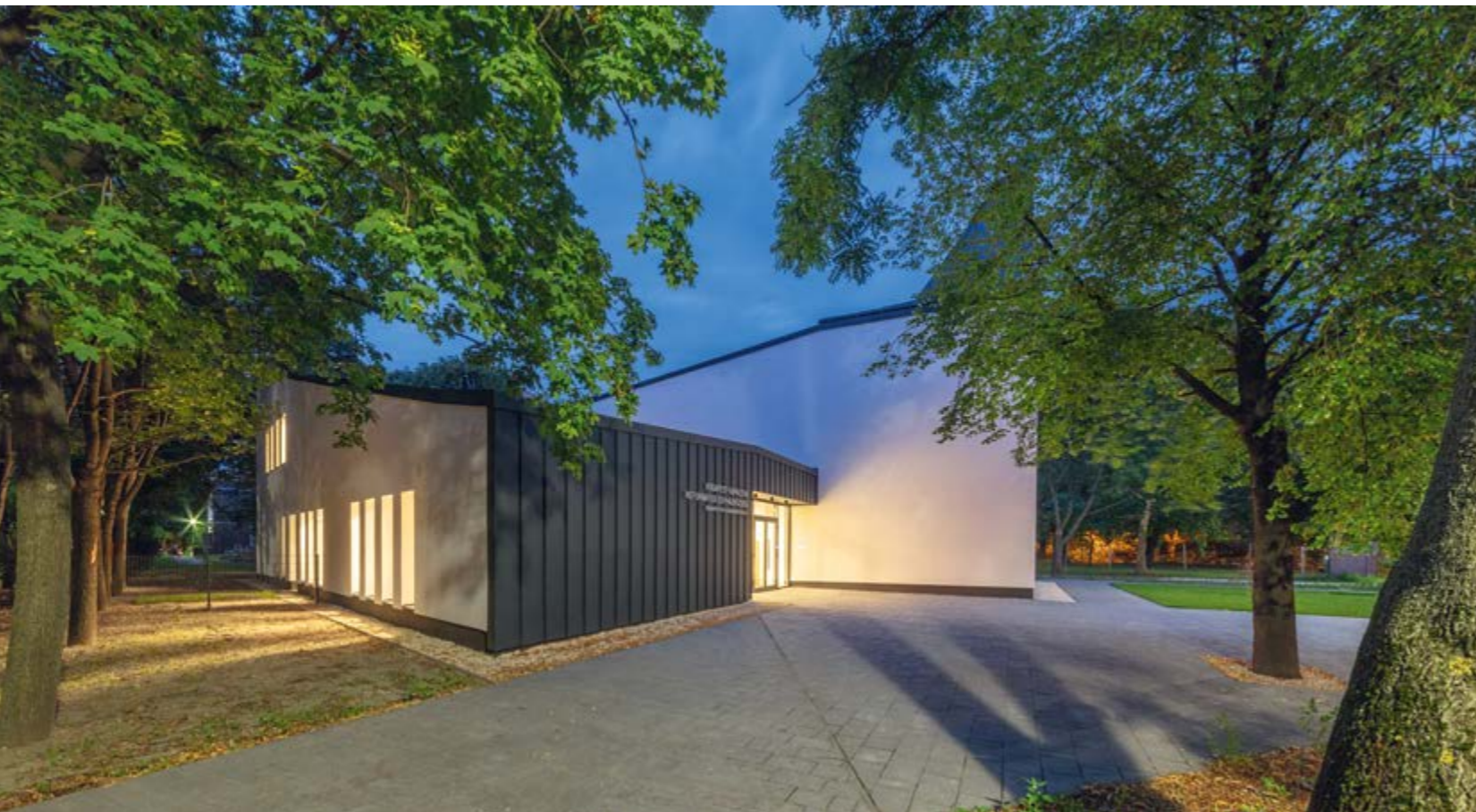
Fás-bokros helyközön, a Fő tér közelében épült, játszótérnyi telken ez a templom.
