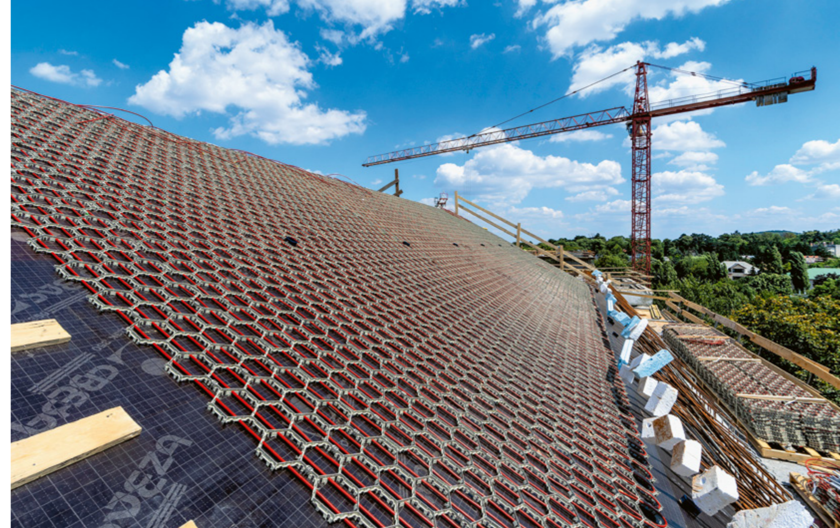
A MOME MASTER koporsófödém zsaluzata a szerkezetbe kerülő hűtő-fűtő panelekkel
