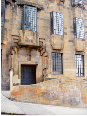
A Glasgow School of Art épülete a tűzvész előtt, Glasgow, Skócia Fotó: Wikimedia Commons
