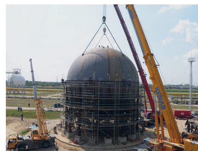
A terméktároló tartály építés közben
